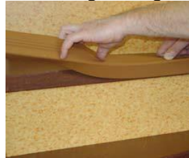
Trapkantprofiel aanbrengen
