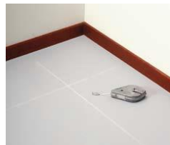
Plaats randpatroon bepalen m.b.v. spatlijn
