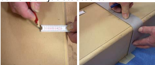
Begin van de trapneus Markeren Hoogte meten
