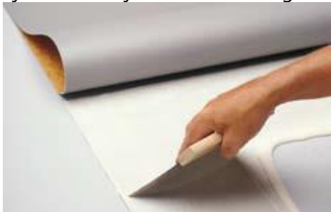
Lijm aanbrengen
