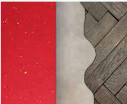
Flexible Spachtelung auf verformungsfähigen Untergründen
