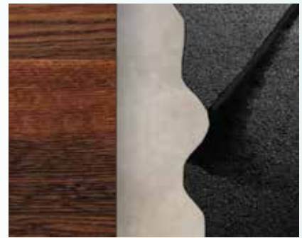
Vergießen und Spachtelung auf Gussasphaltrissen
