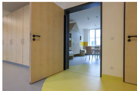
Pfiffiges Detail - anspruchsvolle Ausführung: Intarsien von den Fluren werden in den Zimmern weitergeführt.
