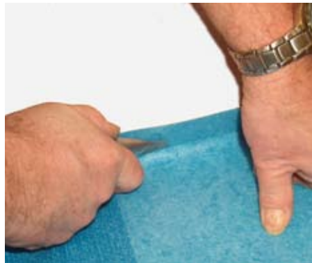
Zijkanten uit de hand passnijden
