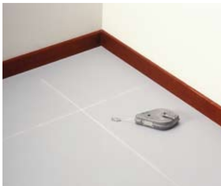
Plaats randpatroon bepalen m.b.v. spatlijn
