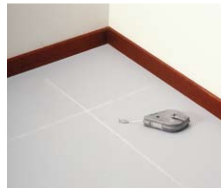
Plaats randpatroon bepalen m.b.v. spatlijn
