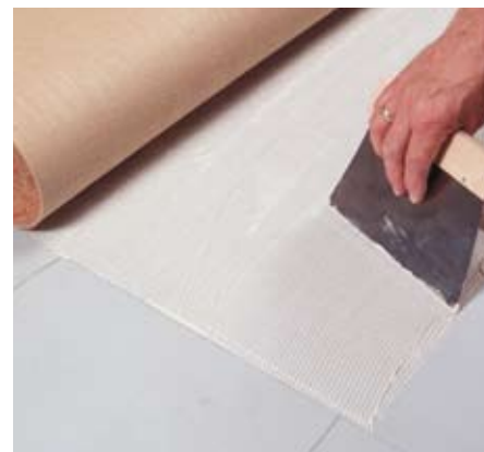
Lijm aanbrengen
