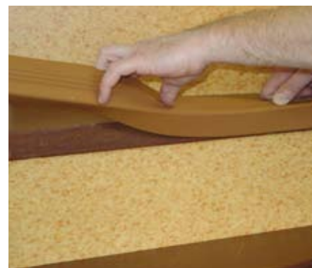
Trapkantprofiel aanbrengen
