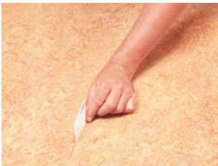
Testen van de naadbreedte
