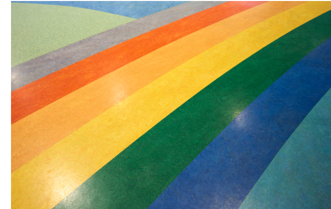
Oben Die Streifen des Regenbogens wurden unverfugt verlegt und zeigen bis heute keine Mängel.
