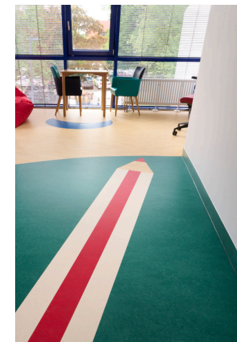
Oben Die Streifen des Regenbogens wurden unverfugt verlegt und zeigen bis heute keine Mängel.
