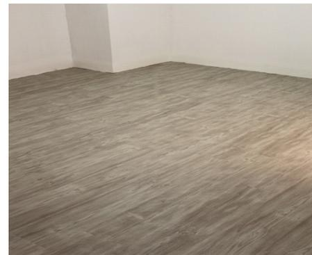
**6** Attendre 72 heures avant de réinstaller le mobilier. Pour les taches de colles, utiliser un chiffon imbibé, soit d'alcool ménager, soit de White Spirit. Ne pas utiliser d'acétone qui risquerait d'endommager la surface.
