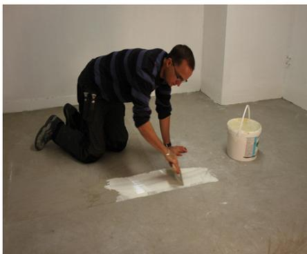
**2** Encoller le support avec une colle acrylique à raison de 250gr/m<sup>2</sup>. Respecter le temps de gommage et le temps ouvert (selon conditions du fabricant).
