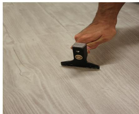
**5** Maroufler ensuite chaque lame avec un marteau à maroufler, puis à la fin de la pose, avec un cylindre d'environ 60 kg. Pour la seconde rangée et les suivantes, veiller à décaler les joints d'un tiers de lame.
