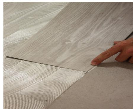
**3** Après avoir laissé gommer la colle, appliquer la première lame le long de l'axe. Pour la deuxième rangée de lames, décaler d'un tiers de lame afin d'obtenir un aspect de pose visuellement décalé.
