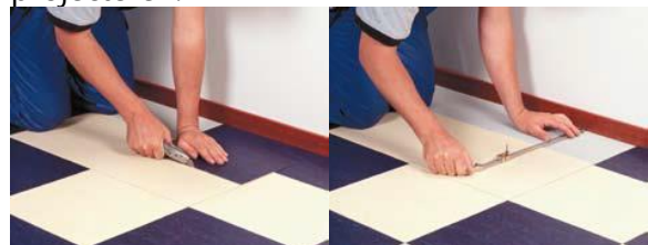
Inkrassen langs een even grote tegel Inkrassen met de lange afschrijver
