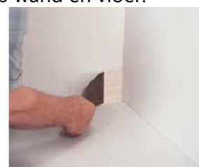
Lijmbed aanbrengen
