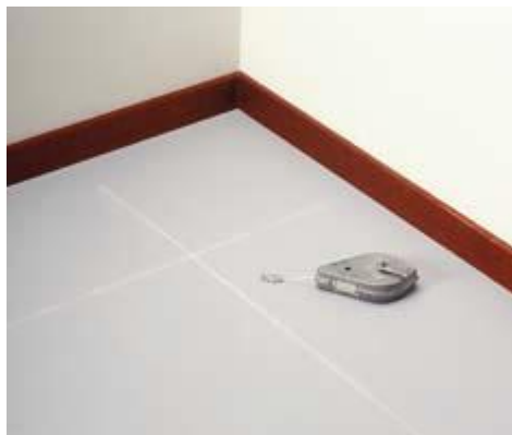
Plaats randpatroon bepalen m.b.v. spatlijn
