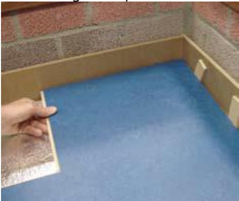
Eerste paneel van de laatste rij plaatsen
