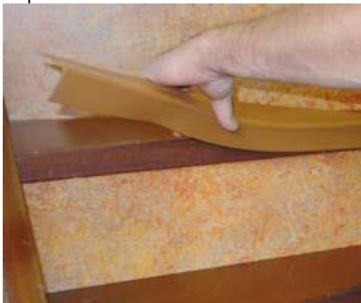
Aanbrengen trapkantprofiel
