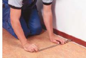
Vorm van de wand inkrassen
