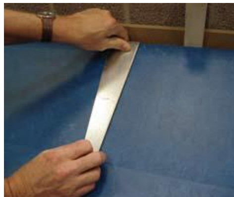
Paneel in de groef trekken met aanslagijzer
