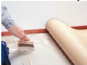
Lijm aanbrengen
