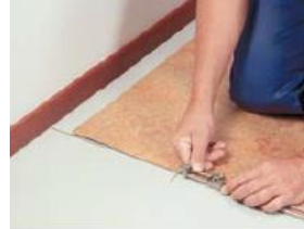
Afstand afschrijver installeren
