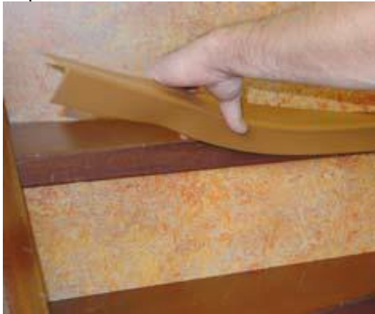
Aanbrengen trapkantprofiel
