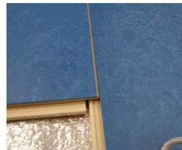
Kleine kier lengterichting
