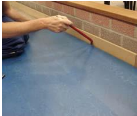
Paneel in de groef trekken met koevoet
