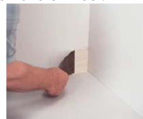
Lijmbed aanbrengen
