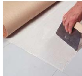
Lijm aanbrengen
