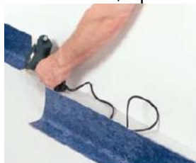
Smelthars aanbrengen
