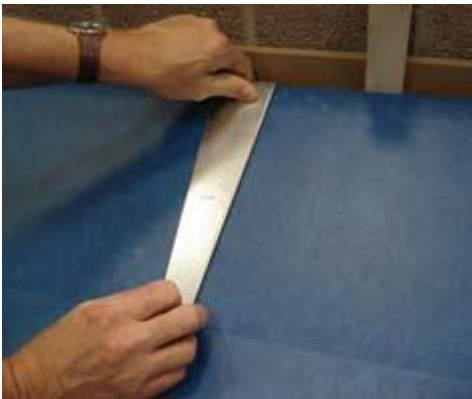
Paneel in de groef trekken met aanslagijzer
