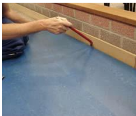
Paneel in de groef trekken met koevoet
