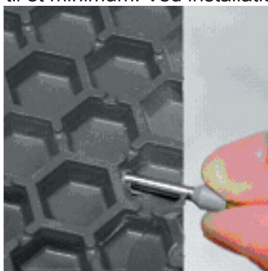
Indfør stik med jordforbindelseskabel.
