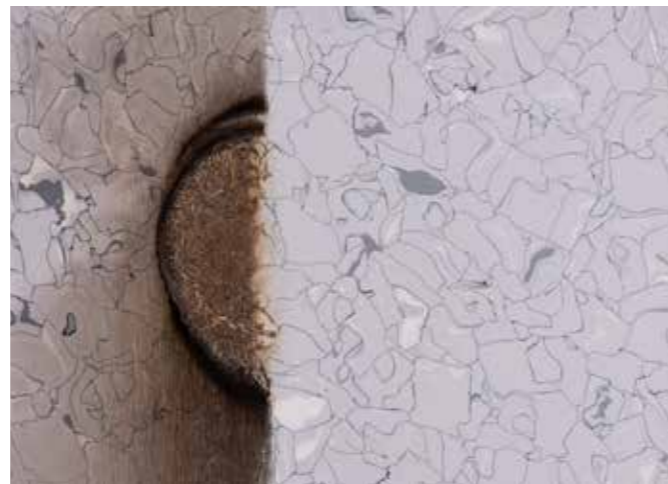
Les traces de brûlures peuvent être éliminées par ponçage.
