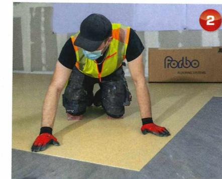
Sichtkontrolle über die gewissenhafte Einbettung des Colorex ESD Bodenbelages in den leitfähigen Klebstoff, um Luftpfeifen zu verhindern.
