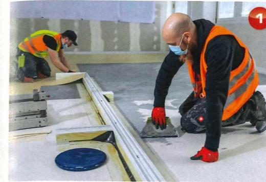
Der leitfähige Klebstoff wird vollflächig auftragen, für eine sichere Ableitung der Aufladung über das System Bodenbelag-Klebstoff-Potenzialausgleich muss je ca. 40 m<sup>2</sup> Fläche mindestens eine Erdung mit Kupferbandstreifen von ca. 1 lfm Länge erfolgen.
