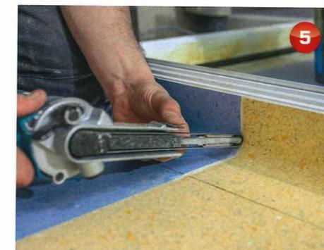
Die saubere Material-in-Material-Verschweißung ermöglicht einen Reinraum gerechten Nahtschluss im geforderten Hohlkehlbereich der Sockelausführung.
