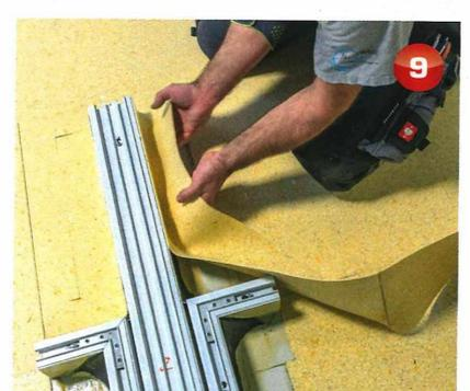
Dank der systembezogenen Hohlkehlleisten und Eckausbildung ist eine homogene Ausführung der Hohlkehlen mit optimalem Anschluss für Reinraum-Wände gegeben.
