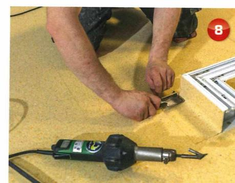
Auch an problematischen Außenecken ist durch die Fähigkeit der Material-in-Material-Verschweißung eine stoßfeste Eckausbildung möglich.
