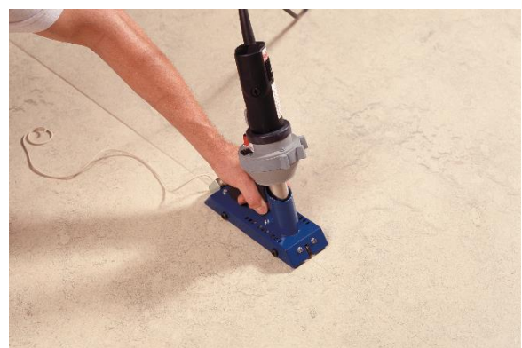
Fig. 13 – Forbo groover
