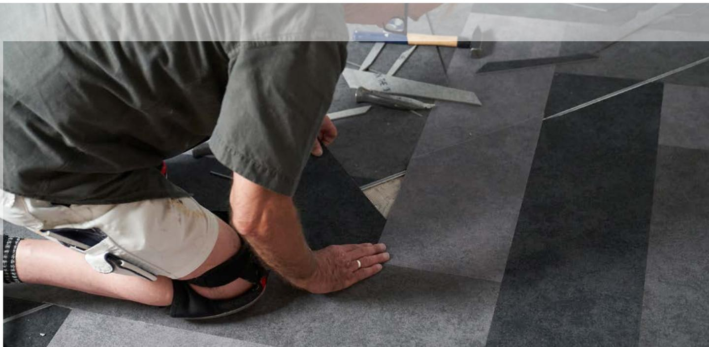
Les revêtements de sol Flotex de Forbo peuvent être posés sur tout support prêt pour la pose. Le support doit être solide, sans fissures, fiable, sec de façon durable et plat.
