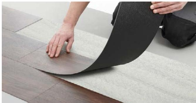
1. Pour la pose, le support doit être sec, solide, porteur et plan. Le cas échéant, les irrégularités doivent être corrigées.
