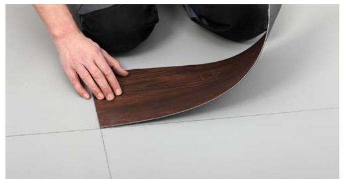
Pour le collage, il convient d'utiliser des colles à dispersion appropriées comme Forbo Eurostar 644 ou des colles appropriées d'autres fabricants (les recommandations de colle peuvent être demandées) La pose du revêtement est effectuée dans le lit de colle en tenant compte des temps d'ouverture de la colle.
