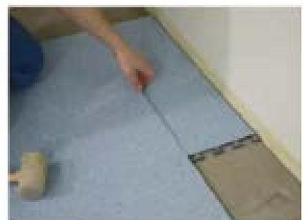
Pour les pièces normalement climatisées avec des variations de température minimales (espaces de travail avec chauffage, climatisation, etc.), une distance par rapport au mur (joint de dilatation) de 3-5 mm est suffisante. Le silicone ou, mieux encore, un mastic de polyuréthane peuvent être utilisés pour le joint de bordure. Pour obtenir un résultat optimal, il convient d'abord d'insérer un cordon
