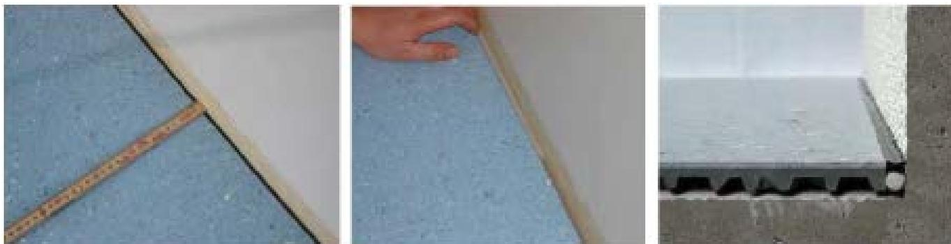
Colorex Plus permet de créer des plinthes creuses étanches et hygiéniques avec des angles rentrants et sortants soudés dans le même matériau que le revêtement de sol. Cette variante de raccordement mural est spécialement conçue pour les zones hygiéniques ou pour les applications conformes à la loi WHG 19.
