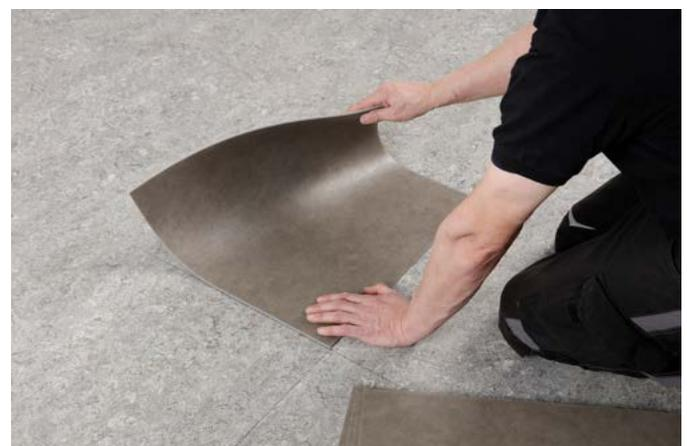
La fixation d'Allura Flex requiert l'utilisation de colles de dispersion appropriées comme Forbo Eurocol 542 (résistant au plastifiant) ou celles produites par d'autres fabricants. « Antidérapants » ne suffisent pas!
