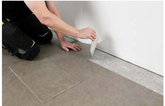
Dans le cas où les murs présentent des courbures ou si le revêtement doit être adapté à des tuyaux de chauffage, il est possible de le couper à main levée avec la lame à crochet ou de le décaler avec le grand trusquin. Une autre solution consiste à créer un gabarit en carton ou autre, dont les contours peuvent ensuite être reportés sur le panneau de revêtement. Le fait de chauffer légèrement le dos du panneau à couper avec un décapeur thermique facilite le mouvement de la lame.
