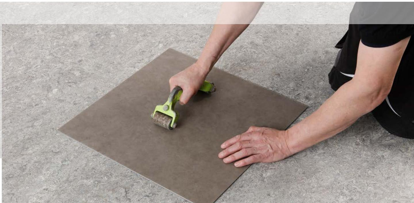
Les revêtements de sols design Allura de Forbo peuvent être posés sur tout type de support préparé en vue de la pose. Le support doit être solide, sans fissures, fiable, sec de façon durable et plat.
