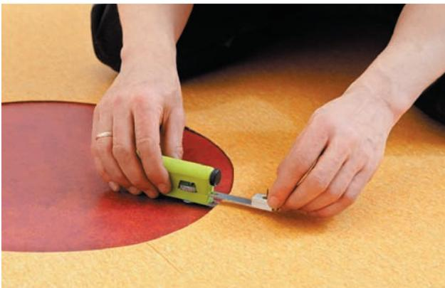
Entlang der angerissenen Intarsie wird der Belag mit der Hakenklinge unterschritten. Wichtig: Der Unterschnitt muss von der Intarsie wegführend verlaufen
