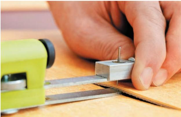
Die Außenkante der Intarsie abtasten und innerhalb dieser grob zuschneiden. Mit dem auf „Dicht“ eingestellten Nahtanreißer die Intarsie auf die Bahn übertragen
