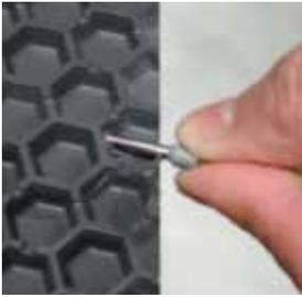
Un ruban de cuivre autocollant est utilisé de préférence pour le raccordement aux dalles (ou un câble de mise à la terre conventionnel). (voir illustration)
