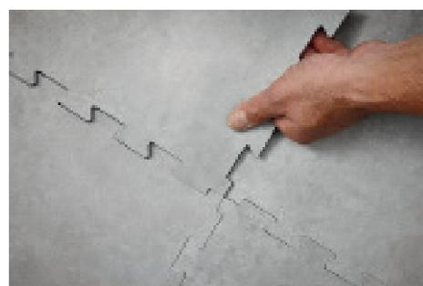
**2** Zunächst die Ecken verbinden und dann die Verzahnung spannungsfrei unter leichtem Druck schließen.
