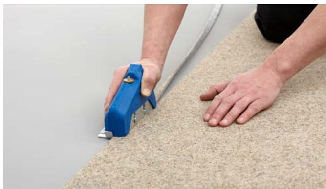
Le deuxième lé est positionné au niveau du joint avec env. 2 cm de juxtaposition et doit être découpé après le collage au plus près du lé inférieur. Un coupe-joint (Linocut) avec une arête de butée plus élevée peut être utilisé ici.
