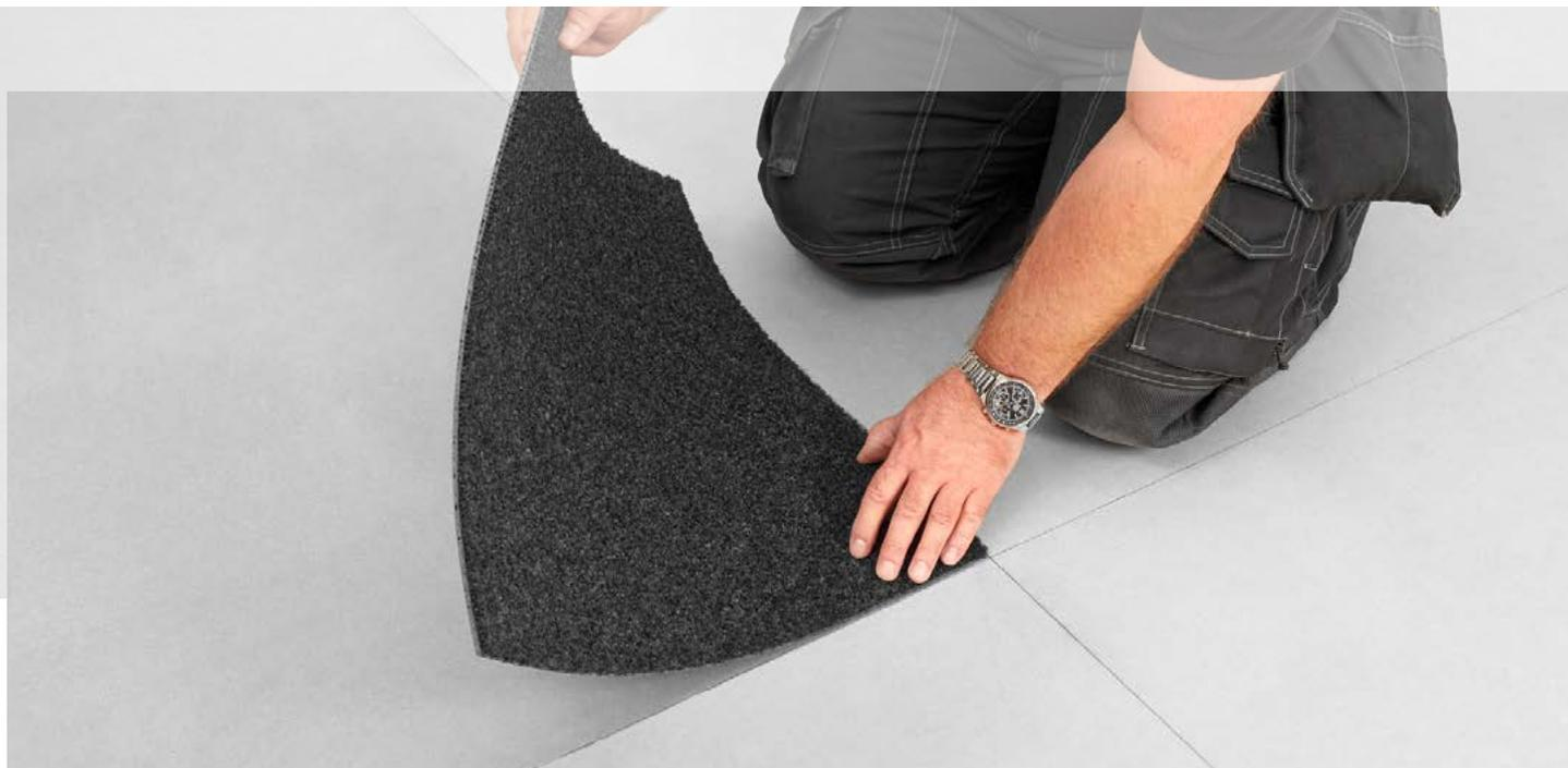
Les revêtements de sol feutre aiguilleté Forte de Forbo peuvent être posés sur tout support prêt pour le revêtement. Le support doit être solide, sans fissures, viable, sec de façon durable et plat.
