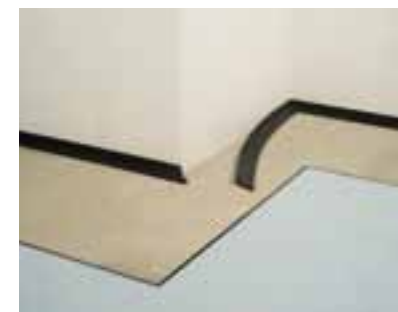
1. Het holplintprofiel wordt los tegen de wand gelegd.
