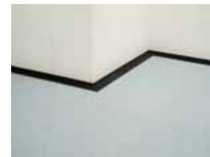
1. Het holplintprofiel wordt los tegen de wand gelegd.
