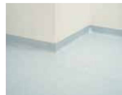
5. Alle componenten kunnen nu thermisch worden gelast voor optimale hygiëne en functionaliteit.
