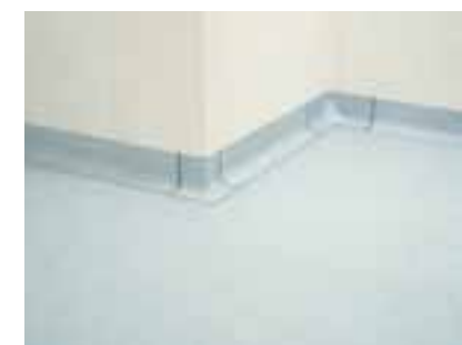
5. Alle componenten kunnen nu thermisch worden gelast voor optimale hygiëne en functionaliteit.
