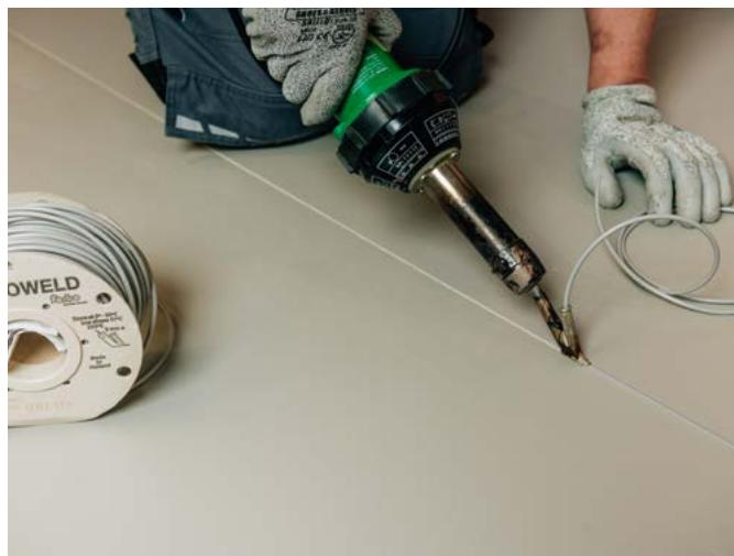
3. Il faut utiliser une buse de soudage rapide avec une ouverture de 5 mm et une sortie d'air étroite.
