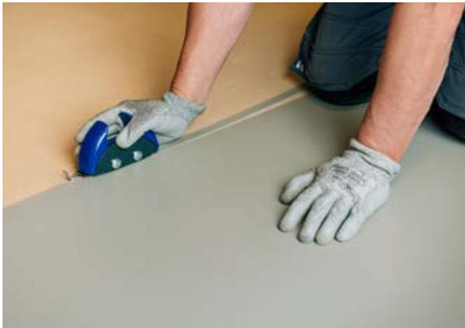
Afin d'identifier à temps un glissement du lé, un marquage au crayon est recommandé le long de l'arête du joint. Afin de garantir une arête de colle rectiligne, au niveau du bord des lés, une ligne ou une bande de colle peuvent être apposées. Au niveau du pli de séchage, il est recommandé, d'enduire le dos du revêtement de colle avant le collage du lé. La colle doit être déposée en fine couche avec un rouleau en fourrure d'agneau ou une spatule lisse env. 20 cm au dessus de la courbure.
