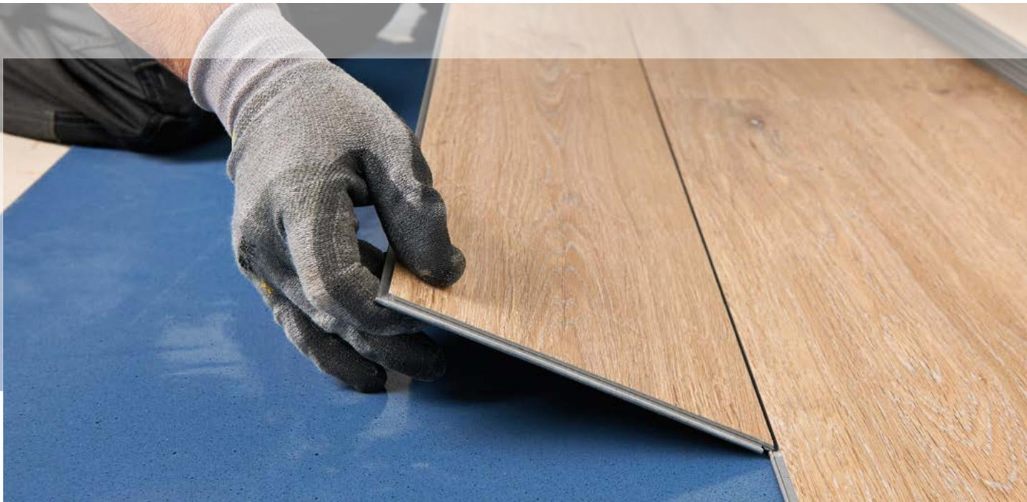
Enduro Click de Forbo peut être posé sur tout type de support préparé en vue de la pose. Le support doit être solide, sans fissures, fiable, sec de façon durable et plat.
