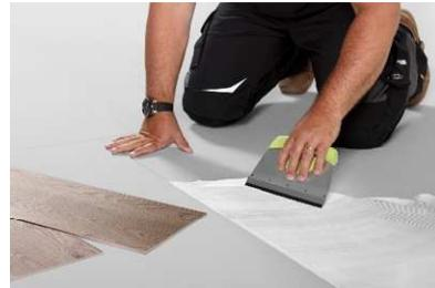
**2)** Entlang des maßgebenden Schnurschläges wird Linoleum-Klebstoff (Eurocol 611) oder gleichwertig, unter Verwendung einer Zahnleiste TKB B1 aufgetragen.
