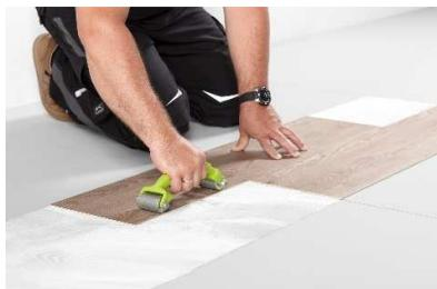
**4)** Der Belag sollte gut angerieben und im Anschluß mit einer ca. 70 kg schweren, mehrgliedrigen Walze angewalzt werden. Achten Sie bitte darauf, den Belag ein zweites Mal nach ca. 15 Minuten in Längs- und Querrichtung anzuwalzen.
