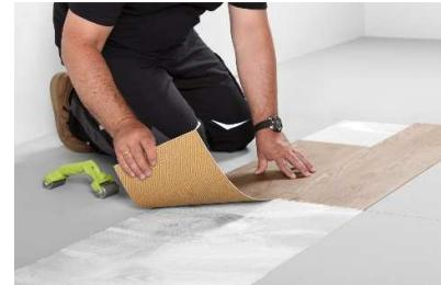
**3)** Die Planken werden innerhalb der angegebenen Einlegezeit ins nasse Klebstoffbett eingelegt. Es ist darauf zu achten, dass nur so viel Klebstoff aufgetragen wird, dass die Einlegezeit nicht überschritten wird. Die Verarbeitungsempfehlungen der Klebstoffhersteller sind einzuhalten.
